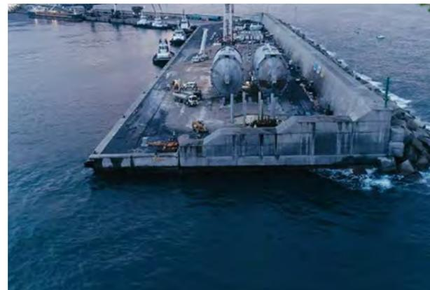
Arlita® ha permitido la construcción del primer prototipo a escala 1:1 de molino eólico Off shore flotante con una plataforma fabricada de hormigón ligero para instalación de una turbina eólica de 2 MW.
